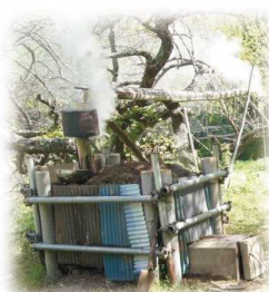
君津大鷲ベルリンの森に設置中の炭焼き装置
